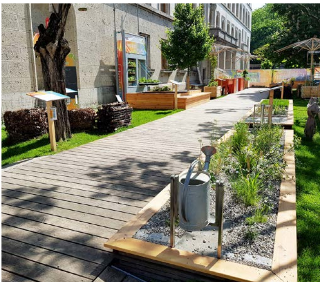
▭ Bild 2: Blick auf den Klimawandel-Garten von der Ludwigstraße. Im Vordergrund ein bepflanztes Regenwasserbeet zur Versickerung von Niederschlagswasser als Beitrag zur „Schwammstadt“.
