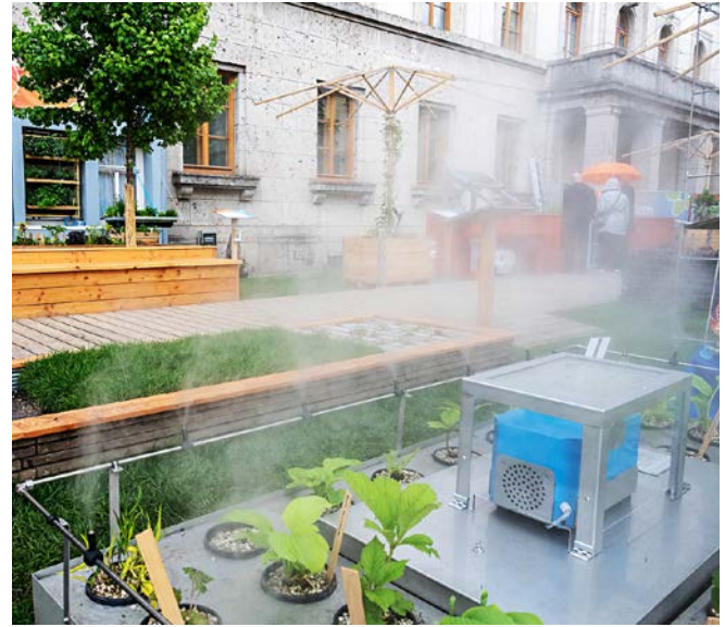
▢ Bild 5: Die Nebelanlage kann im Sommer für eine Abkühlung von bis zu 10 Grad sorgen
