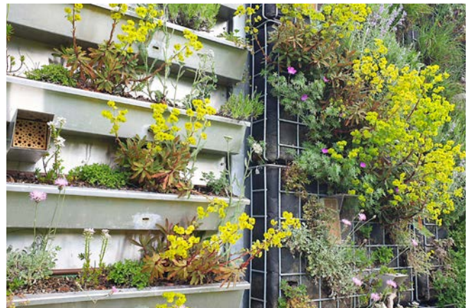
▭ Bild 3: Mit bienenfreundlichen und trockenheitsresistenten Stauden bepflanzt Rinnen- und Gabionensystem an der Südwestwand der Klimaforschungsstation
