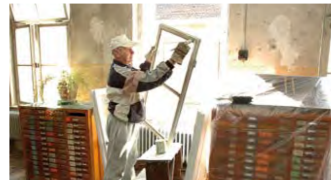
Bei den Umbaumaßnahmen wurde die bestehende Bausubstanz so weit wie möglich erhalten.
