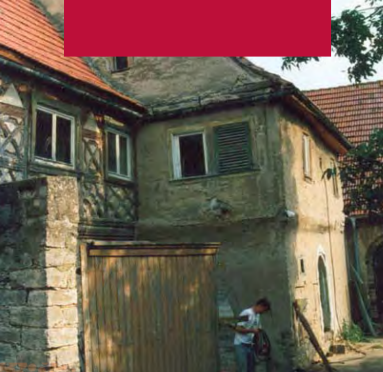
Weingut Heim im Markt Eisenheim: Das leer stehende Wohnhaus aus dem 16. Jh. ist ein repräsentativer Profanbau im dörflichen Umfeld.
