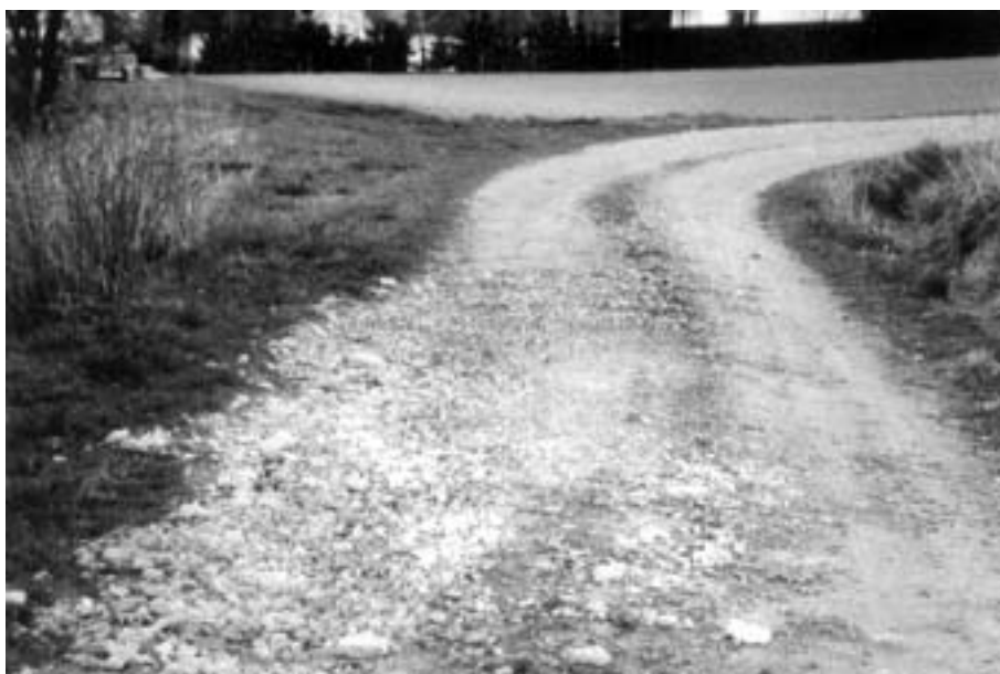
Abb. 33: Wegauffüllung mit Bauschutt
