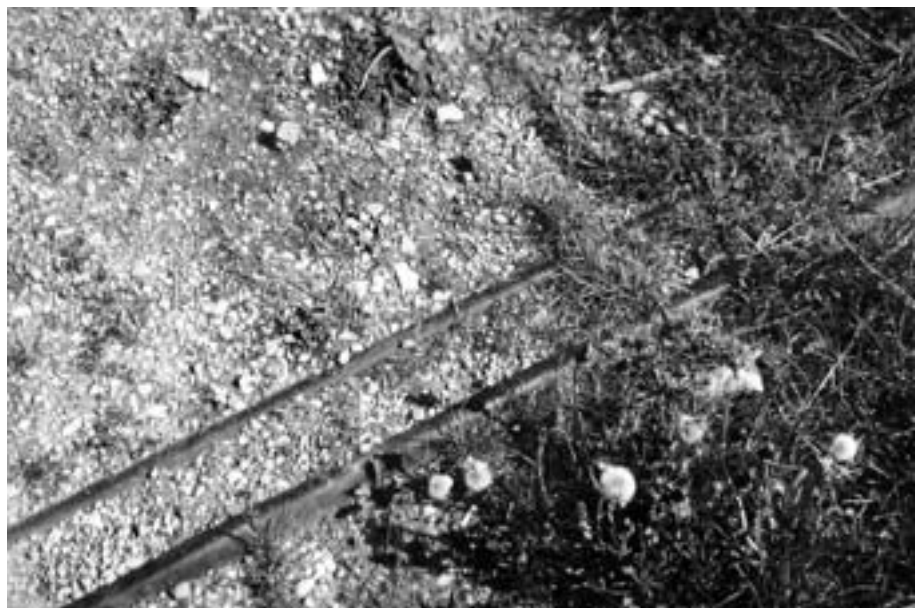
Abb. 31: Versandete und funktionsunfähige Quer- entwässerungsrinne
