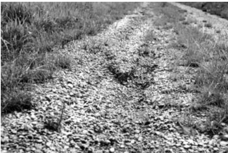
Abb. 21: Oberflächenerosion auf einem ländlichen Weg mit mehr als 8 % Längs- neigung
