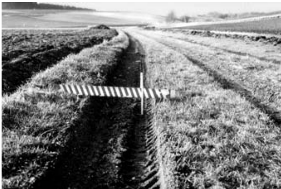
Abb. 26: Spurrinnenbildung auf einem ländlichen Weg der Altersklasse 5 mit überwiegend landwirtschaftlichem Verkehr
