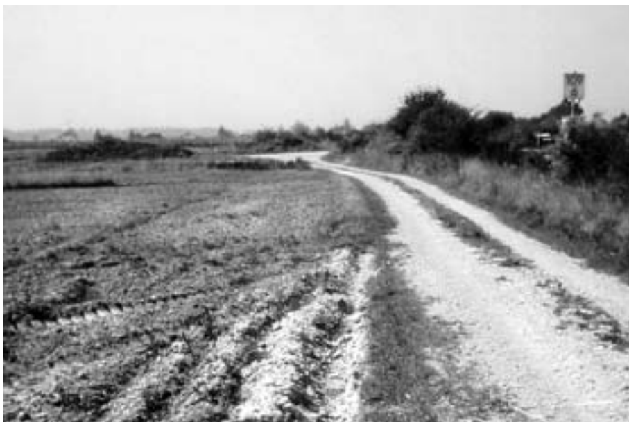
Abb. 10: Ländlicher Weg mit ausgeprägten Bankett- schäden durch Anpflügen der Bankett- und Befesti- gungssubstanz
