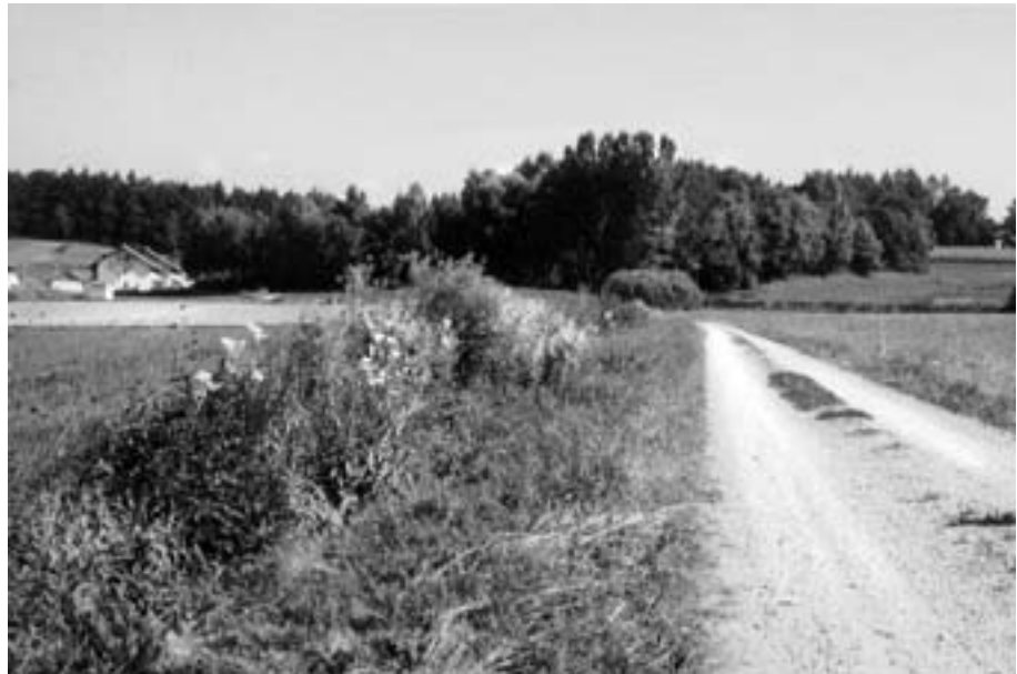
Abb. 30: Zugewachsener Entwässerungsgraben
