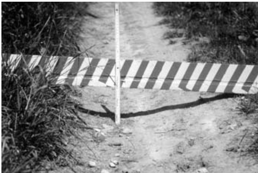
Abb. 4: Ungebundene Befesti- gung mit Spurrinnen von 10 bis 15 cm Tiefe
