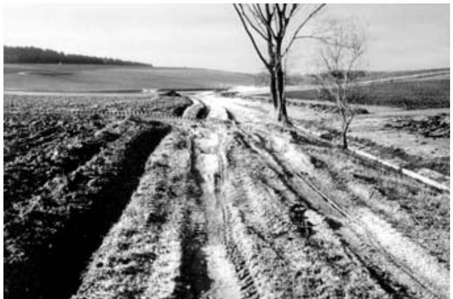
Abb. 9: Ländlicher Weg mit zerstörter Substanz bei ausgeprägten Spur- rinnen, Mulden und Verdrückungen
