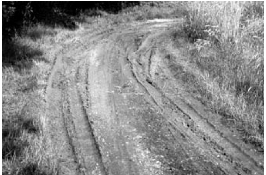
Abb. 8: Ländlicher Weg mit starker Verschmutzung der gesamten Oberfläche durch bindiges Material und Schmierschicht- bildung bei Nässe
