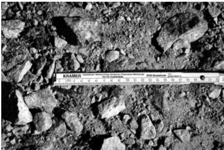
Abb 6: Ungebundene Befesti- gung mit loser Ober- flächenstruktur, fehlen- dem Feinkorn und zu grober Körnung
