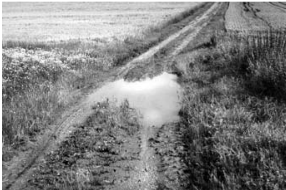
Abb. 28: Geländeebener Weg mit geringer Längsneigung und ohne Entwässerungs- einrichtungen
