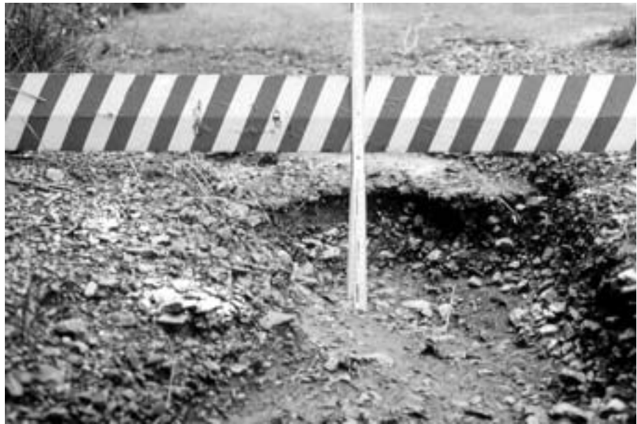
Abb. 29: Ausspülungen und Schlaglochbildung im Übergangsbereich von gebundener und unge- bundener Befestigung
