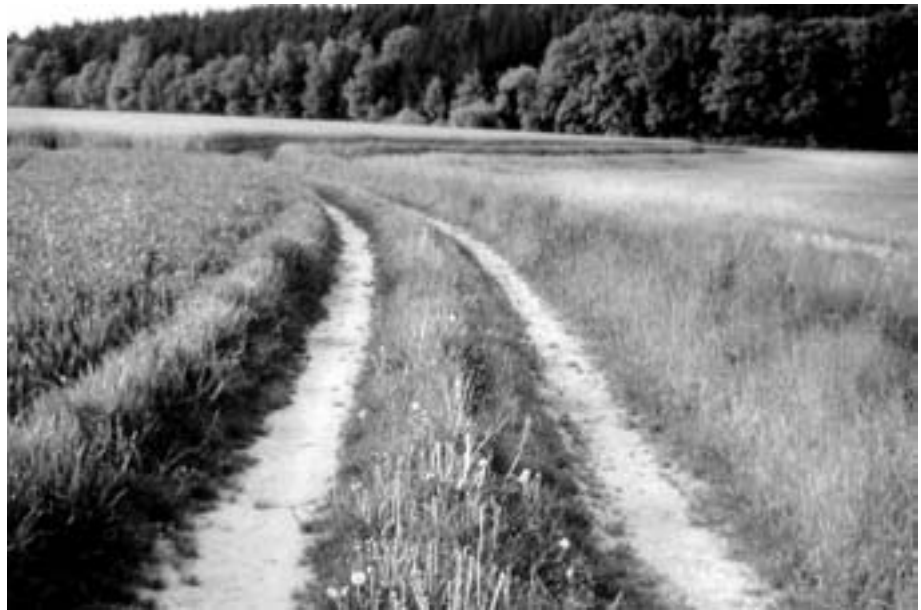
Abb. 7: Ländlicher Weg mit stark hochgewachsenen Banketten und Mittel- streifen (gegenüber den Fahrstreifen um mehr als 15 cm überhöht)
