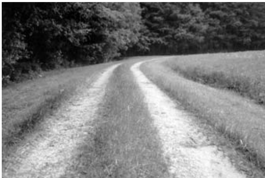
Abb. 1: Landschaftsgebundener ländlicher Weg mit ungebundener Befesti- gung und begrüntem Mittelstreifen
