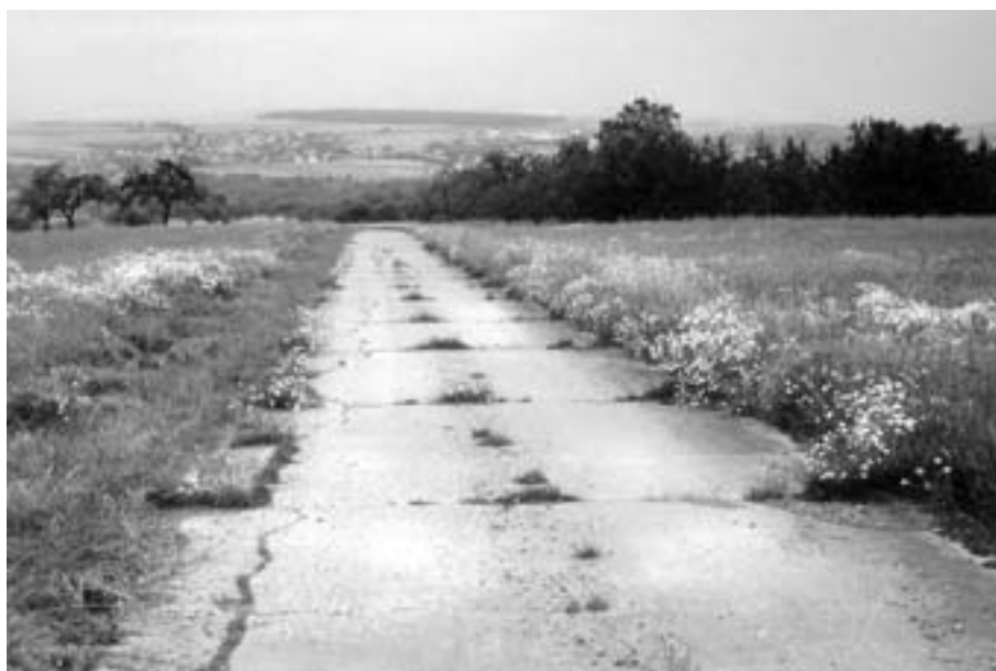
Abb. 2: Älterer ländlicher Weg mit Betondecke
