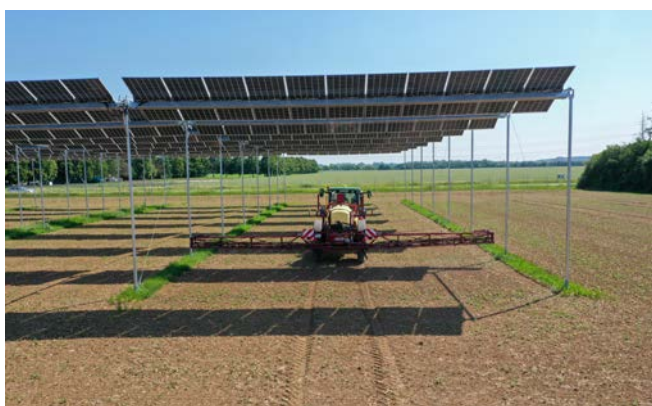
▣ Bild 3: Pflanzenschutzmittelapplikation unter einer hoch aufgestellten Agri-PV-Anlage. Es ist Vorsicht geboten, um Schäden an der Pflanzenschutzspritze und der Aufständerung zu vermeiden. (Foto: Malte Stöppler)
