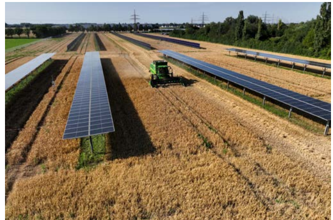
▣ Bild 1: Ein Mähdrescher erntet Wintergerste zwischen einachsigen nachgeführten Agri-PV-Modulreihen (Foto: Malte Stöppler/TFZ)
