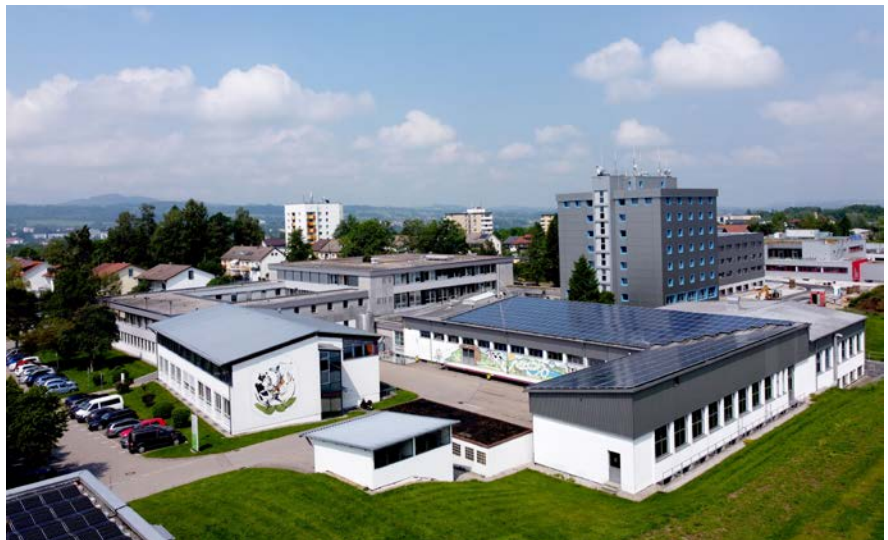
Bild 1: Gesamtansicht des LVFZ Kempten. (Foto: LVFZ Kempten)
