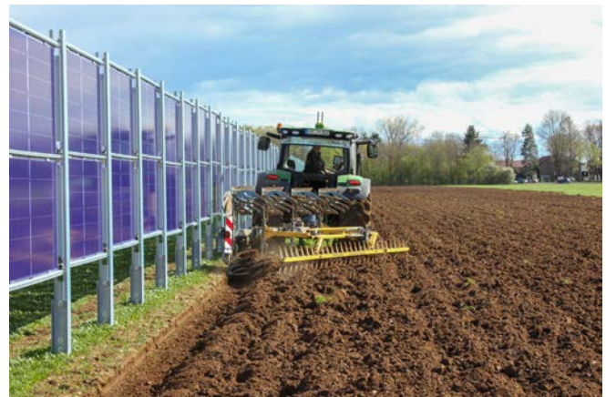
Bild 2: Pflugeinsatz in einer vertikalen Agri-PV-Anlage. Durch die Pflugfurche erhöht sich der Abstand von der Anlage zum bewirtschaftbaren Bereich. (Foto: Malte Stöppler)
