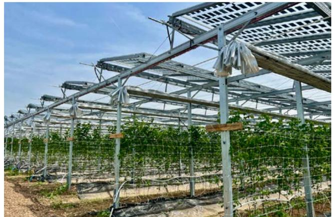
▭ Bild 8: Insolagrün der Firma Insolight über Himbeeren der Bioschmidt GmbH – Das System soll in Zukunft mit undurchsichtigen Modulen getestet werden (Foto: Insolight)
