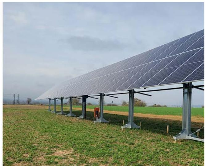
■ Bild 5: Prototyp des hoch aufgeständerten Trackingsystems der Firma Gillig + Keller in verschiedenen Einstellungen (Foto: Jim-Lukas Münch)
