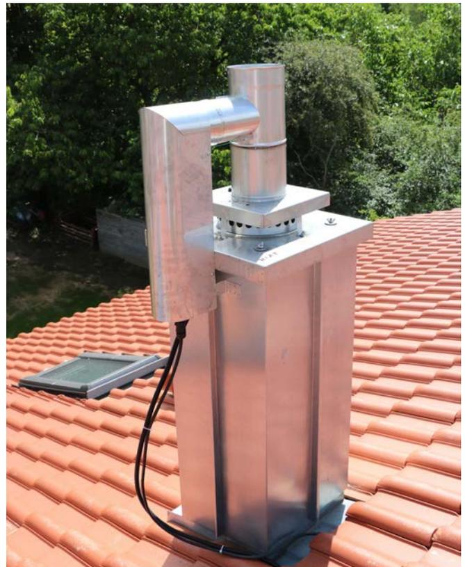
Bild: Ein auf der Schornsteinmündung installierter Staubabscheider „OekoTube Outside“. (Foto: TFZ)
