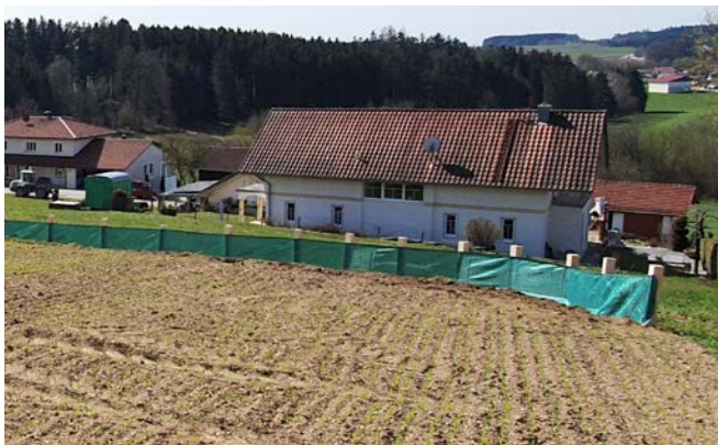
Bild 5: Fertig aufgestellter Sedimentfangzaun (Foto: Theresa Scherm)
